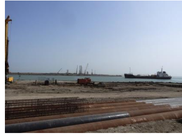
建設中のアリヤート港
