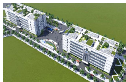
多層階工場建設中
