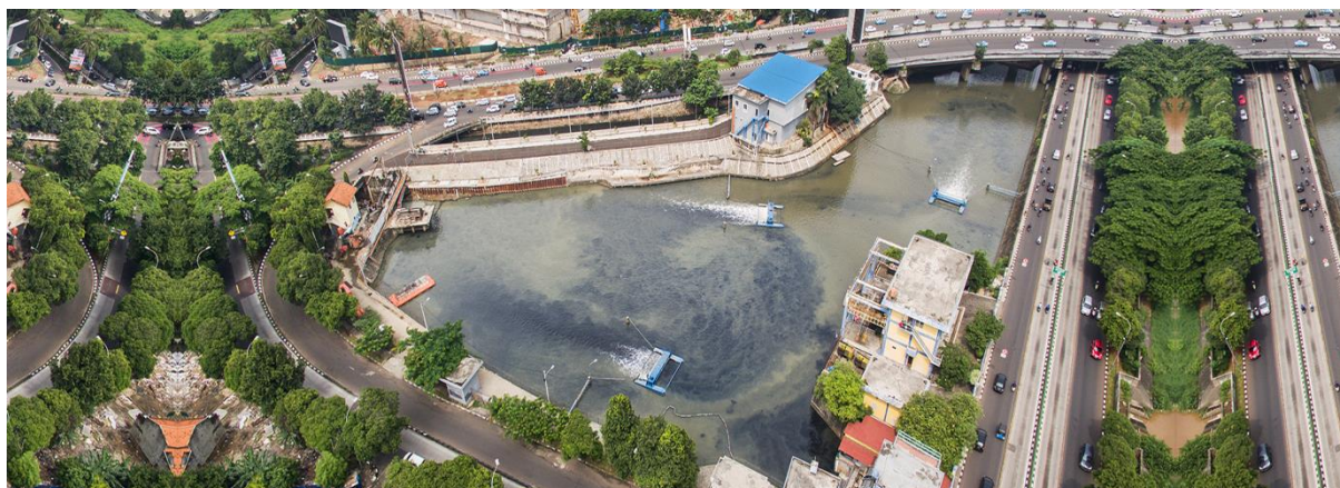
図 3-6 ジャカルタ中心部の Jalan Setiabudi にある下水処理施設
