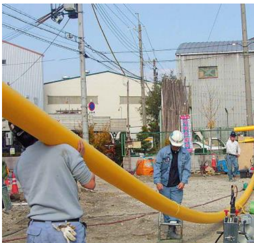
ガス用PE管施工風景とガス用PE管融着機器（レッキス工業提供）
