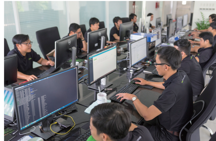
ライナン・テクノロジーのデータセンター(チャビン省チャビン市ロンドック村ビンフン集落)
