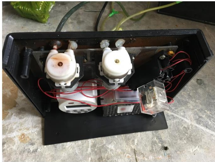
写真 2-15 グラスボックス用ポンプモーターの腐食具合
