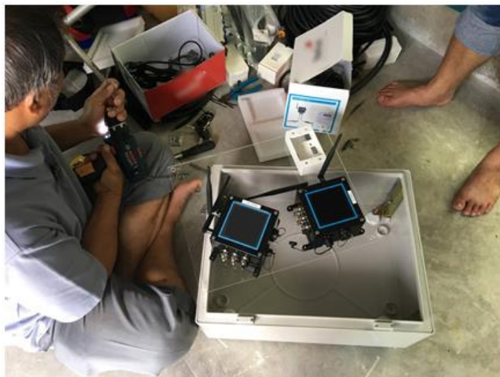
写真 2-5 センサーステーションの組み立ての様子
