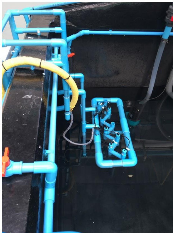
写真 2-9 水位可動式フローターの設置風景
