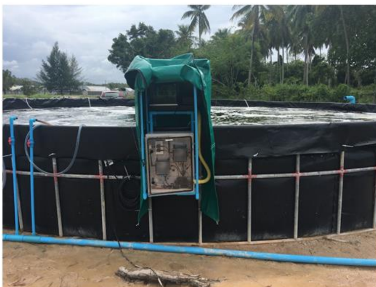
写真 2-13 屋外養殖池へのガラスボックス設置風景
