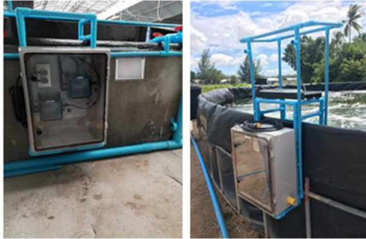
写真 2-18 屋内養殖池及び屋外養殖池へのセンサーステーション設置風景
