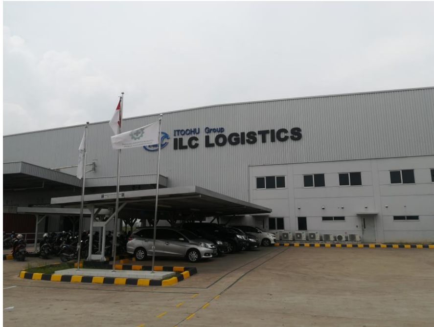
2-3-1-1 写真8 Jakarta 郊外の大規模 B2B 倉庫
