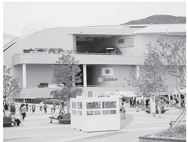
来場者アクセスの良い、会場中心に近い1階に配置されている日本館
