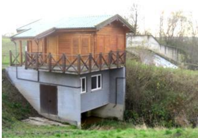
タボル川左岸に建つマイクロ水力発電所
