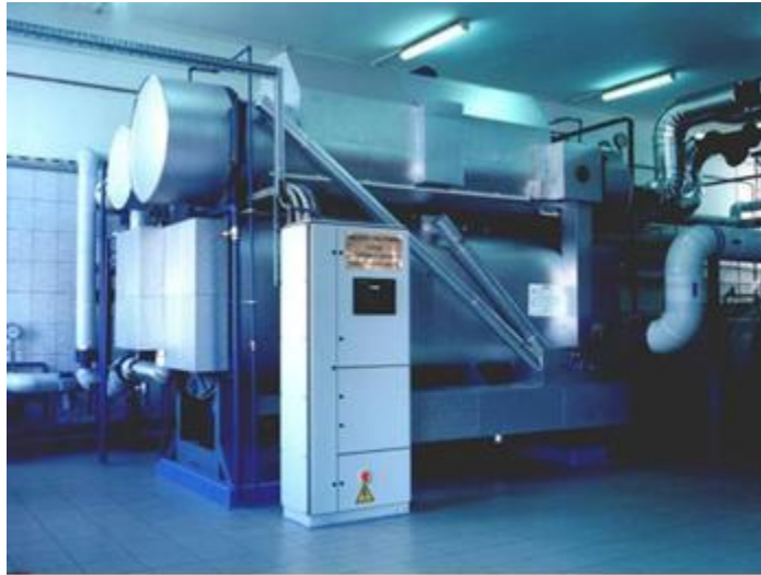
ゲオテルミア・マゾビエツカのヒートポンプ(写真: 同社提供)
