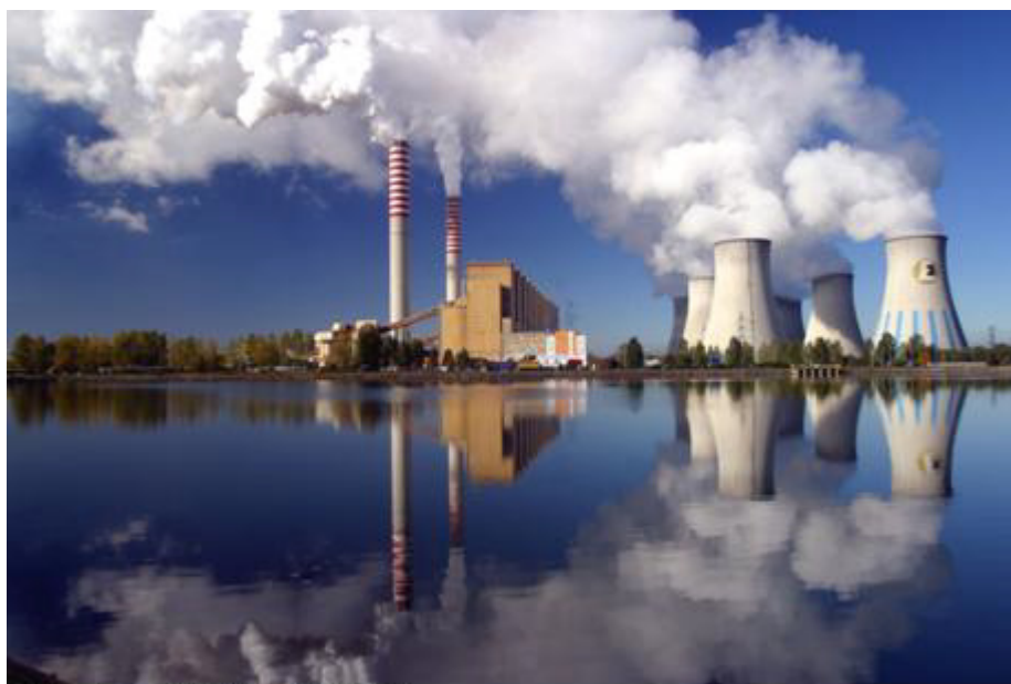
ベウハトゥフ石炭火力発電所
