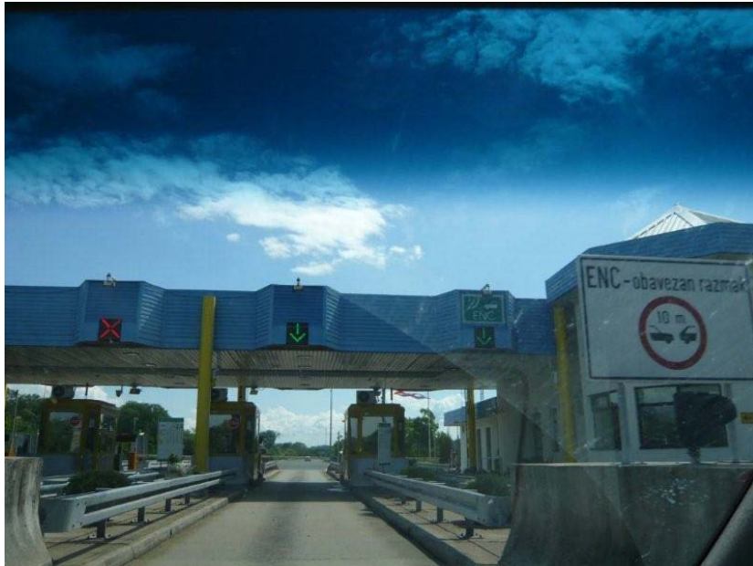
ETCレーン ＜クロアチア＞
