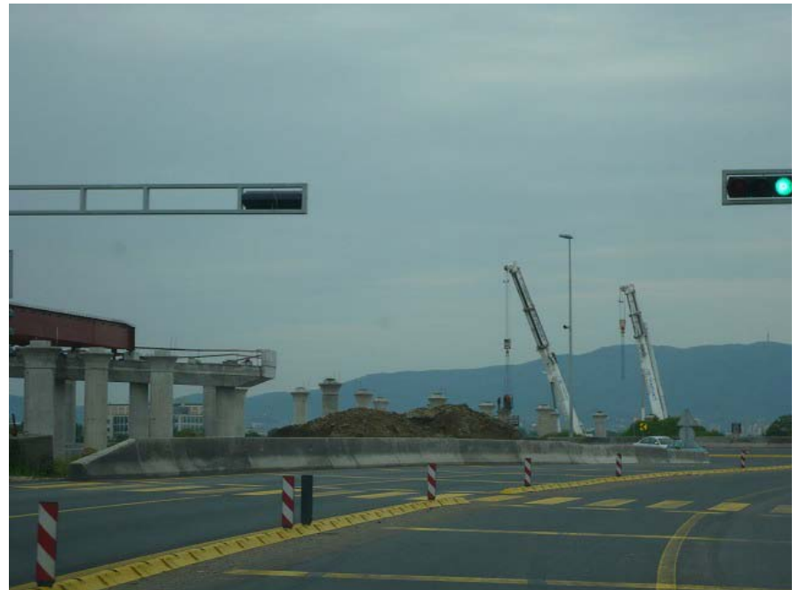
②ザグレブ郊外における高速道路建設工事(クロアチア)
