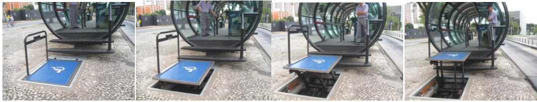
バリアフリーの油圧式昇降機。全てのチューブに設置されている。
