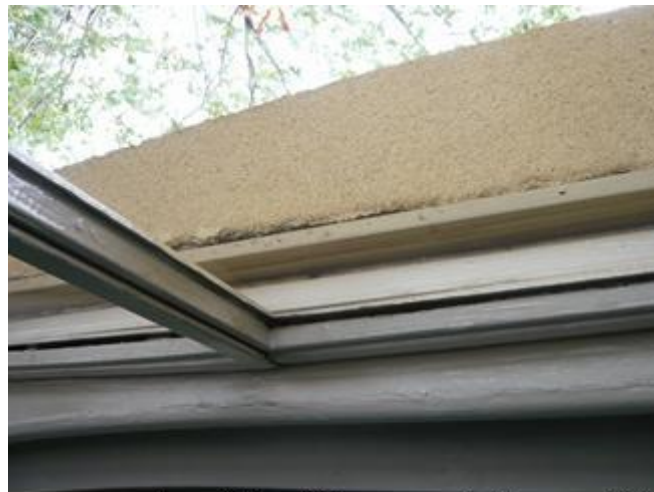
スペインの古い建物の単板ガラスの窓枠レール部分 (室内側から撮影)
