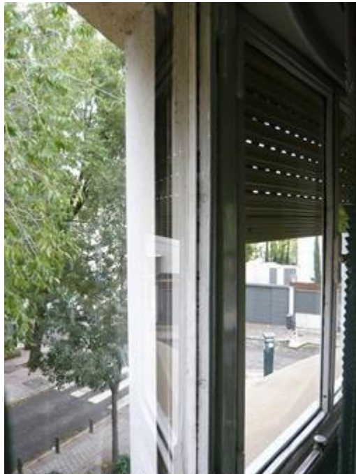
途中まで下ろされた状態のシャッター (写真右側の窓の外側)
