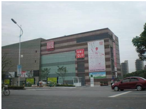
【蘇州泉屋の外観】
