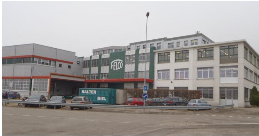
フェルコの工場社屋。事業規模拡大に伴い建て増したため、右側、中央、左側のデザインが異なる。(筆者撮影)
