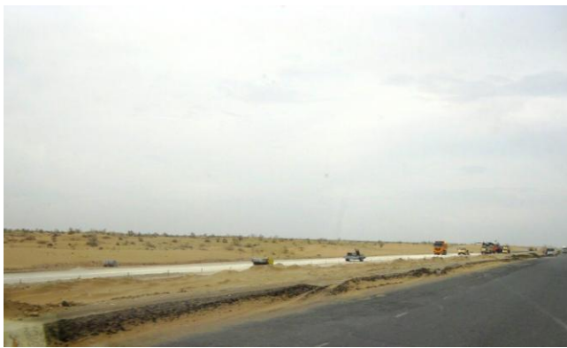
A380。ガズリ - トゥルトクリ 道路建設が進められている区間(右側)。
