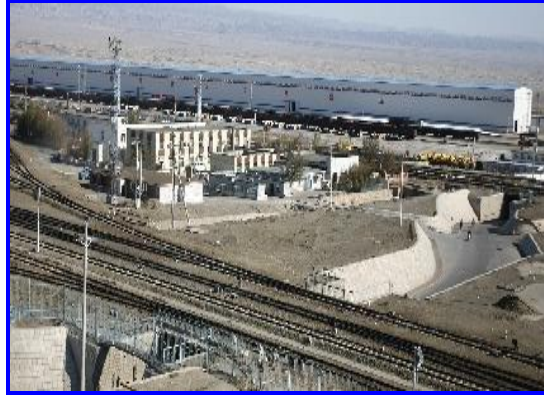
阿拉山口駅コンテナ積替上屋
