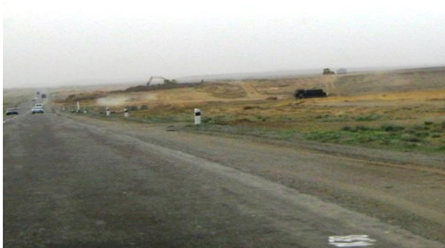
A380。右は建設中の道路。
