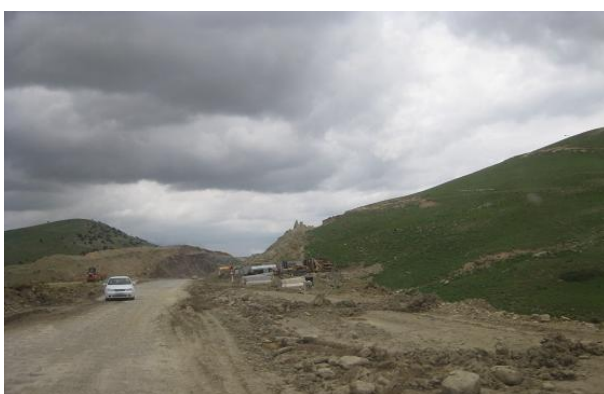
M39。デフカナバード - テルメズ。道路の拡張工事を行っている(右側)。
