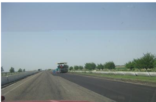
M39。舗装工事中の道路
