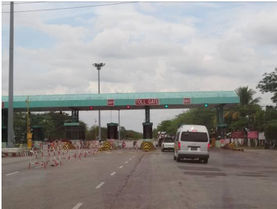
写真③ バゴー～ヤンゴン間の料金所
