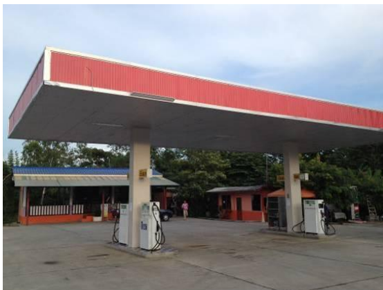
写真① 給油施設の状況
