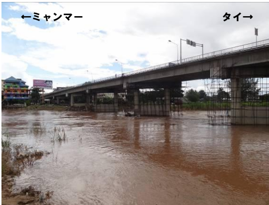
写真⑦ タイ・ミャンマー友好橋
