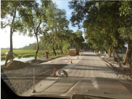
写真⑦ 道路工事(コーカレイ周辺)
