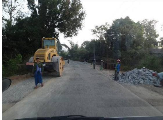
写真⑧ 道路工事(パアン周辺)
