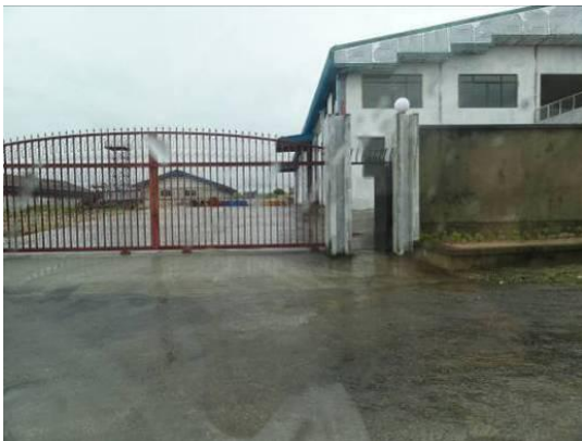
③MTZ 内にある物流倉庫の様子
