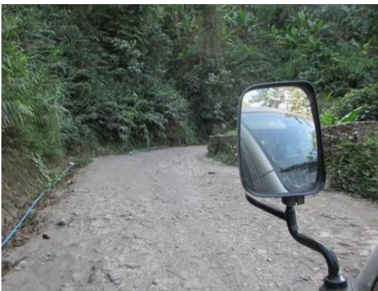
写真③ 劣悪な道路状況
