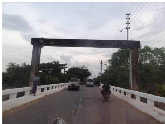
写真④ ウォー橋の様子
