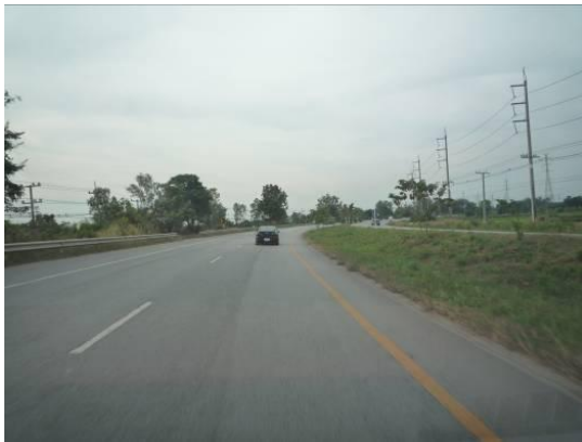
写真① 片側2車線道路
