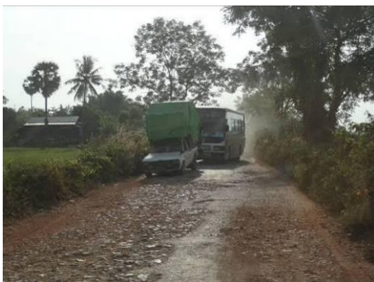
写真⑤ 陥没を避けて走る車両
