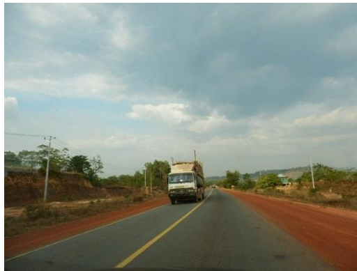
■国道 4 号線、舗装状態は問題ない
