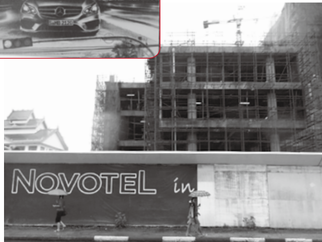
建設中のノボテルホテル (ヤンゴン)
