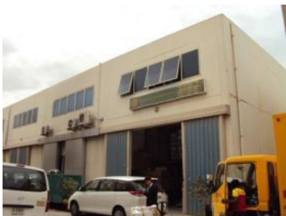
同社が入居する建物外観
