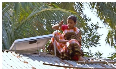
屋根の上で作業中
