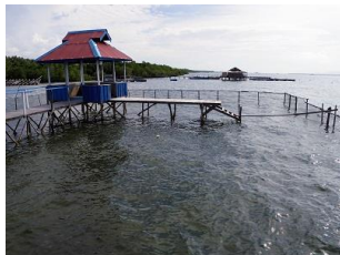
伝統的な養殖施設。杭を直接海底に打ち込んでいる。
