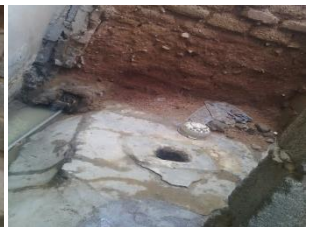
トイレ(右写真にある穴)は浴場と同じ場所にあり、排水を外に出す溝が壁際に掘られている。
