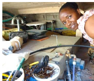
1万リットルの貯水槽 コンクリートの下に埋め込まれている。
