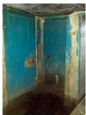
共用トイレ・浴室の扉
