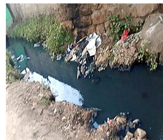
建物からの排水溝は、より大きな未整備の水路に繋がっている
