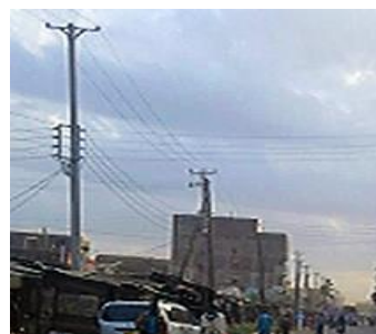
Dandora地区の送電線
