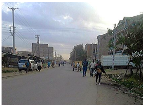
Dandora地区の舗装道路
