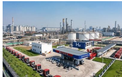
エコパワー水素製造プラントおよび電解槽およびその他の機器製造
