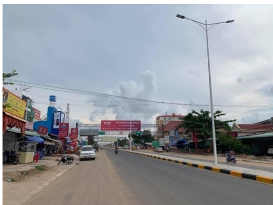
現在のベトナム国境付近の道路の状況（二車線に拡幅されているが、レーン線は未設置）
