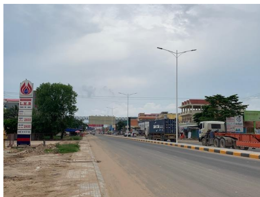
現在のベトナム国境付近の道路の状況（二車線に拡幅されているが、レーン線は未設置）
