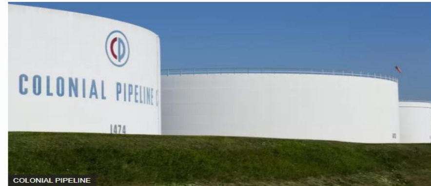
米ジョージア州にあるコロニアル・パイプラインの石油備蓄タンク
