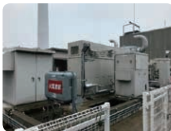
左：アンモニア専焼可能な50kW マイクロガスタービン発電装置（産総研）
