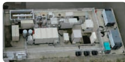
左：アンモニア専焼可能な50kW マイクロガスタービン発電装置（産総研）
